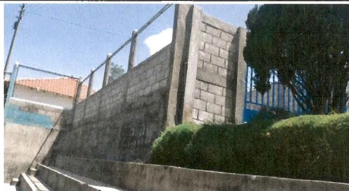
Foto 3: Vista del muro perimetral de block y malla, finalizado, ubicado a la derecha de los edificios escolares, pegado a los graderios del campo de futbol.
